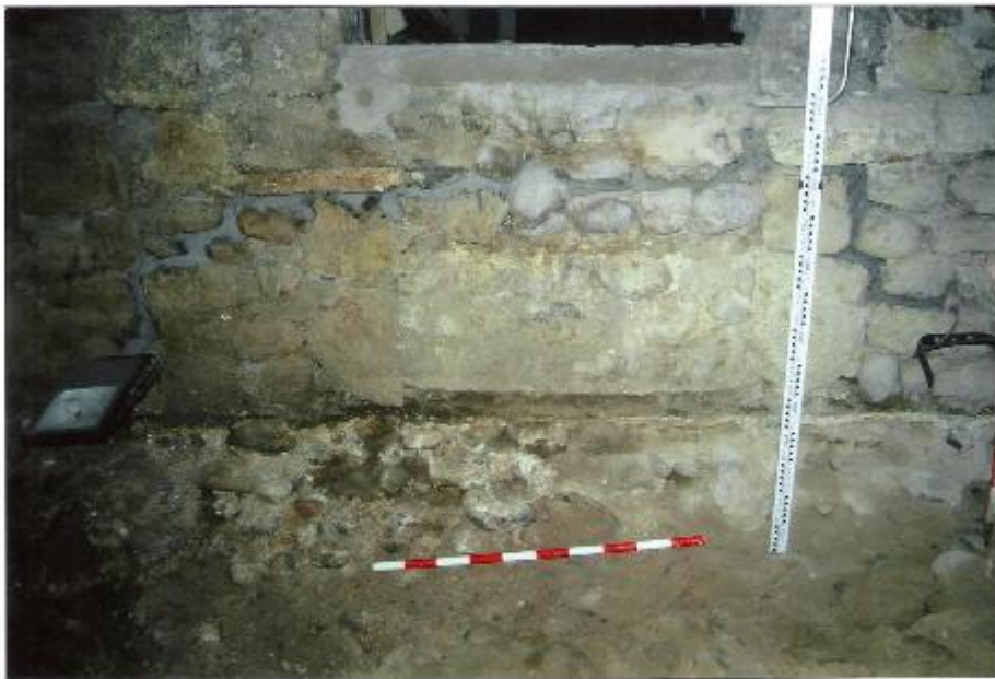
28 y 29. Estratigrafía bajo el dintel de la actual puerta de acceso en el paramento oeste del patio de la torre.
