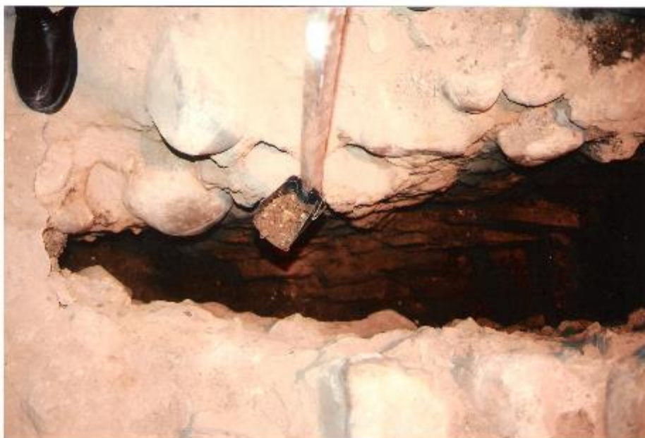
11. Pasadizo, excavación de la grieta: retirando relleno plenomedieval con útil construido a tal fin.
