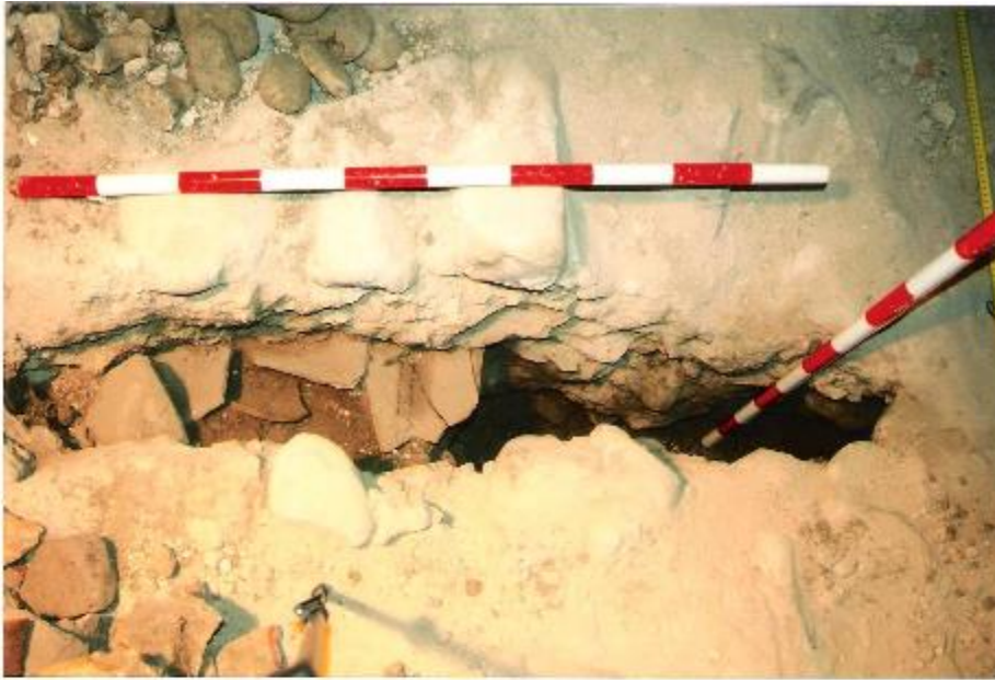
avación de la grieta: U. E. 1010, nivel constructivo aislante de tejas con la parte cóncava hacia arriba .
