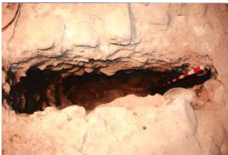
12. Excavación de la grieta: aparición de interfaz bajo el relleno anterior.
